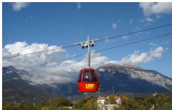
Die neue Luftseilbahn Rhäzüns / Feldis
